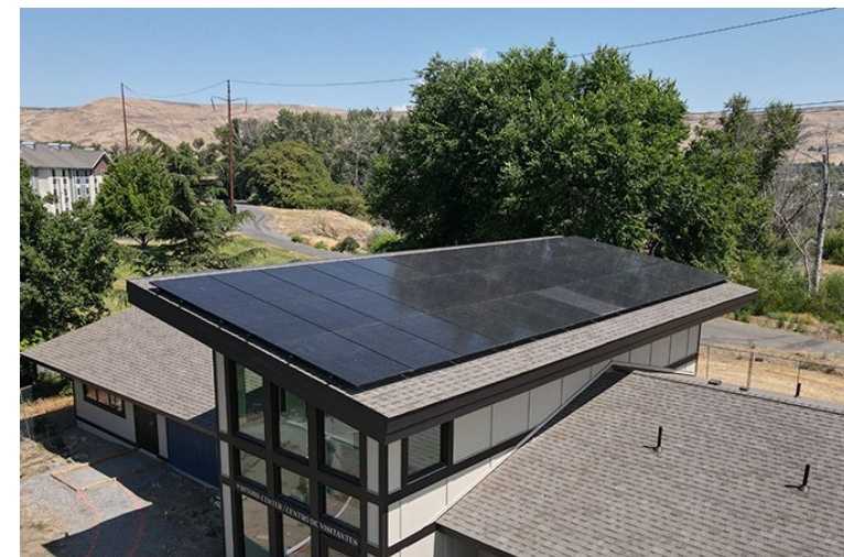
Centro de Visitantes de la Fundación Greenway, 15.33 kW por paneles solares
