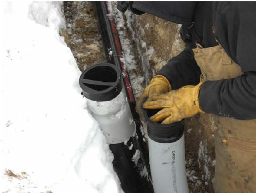
**Figure 28—Plugging the Conduit**
