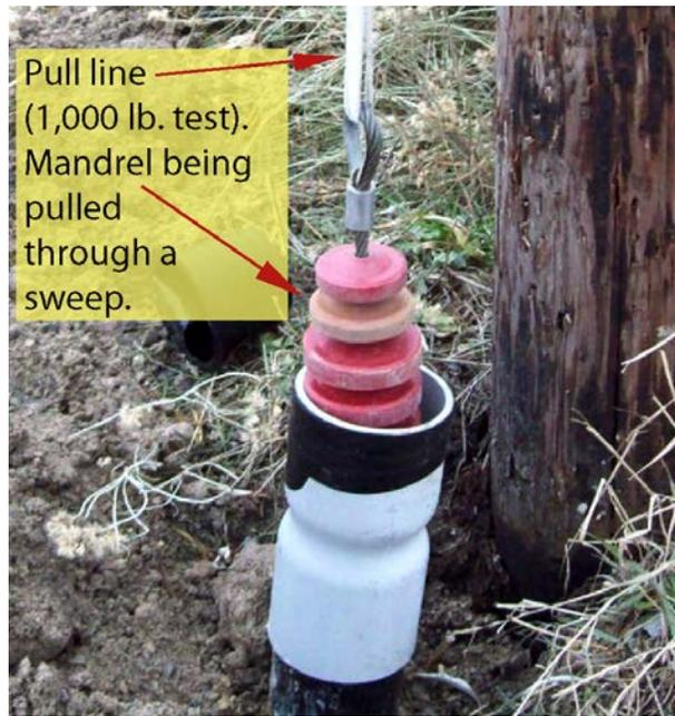
**Figure 27—Conduit Proofing**
