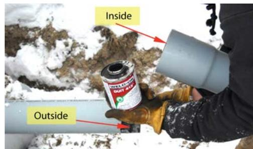
**Figure 24—Applying Glue to Conduit**
