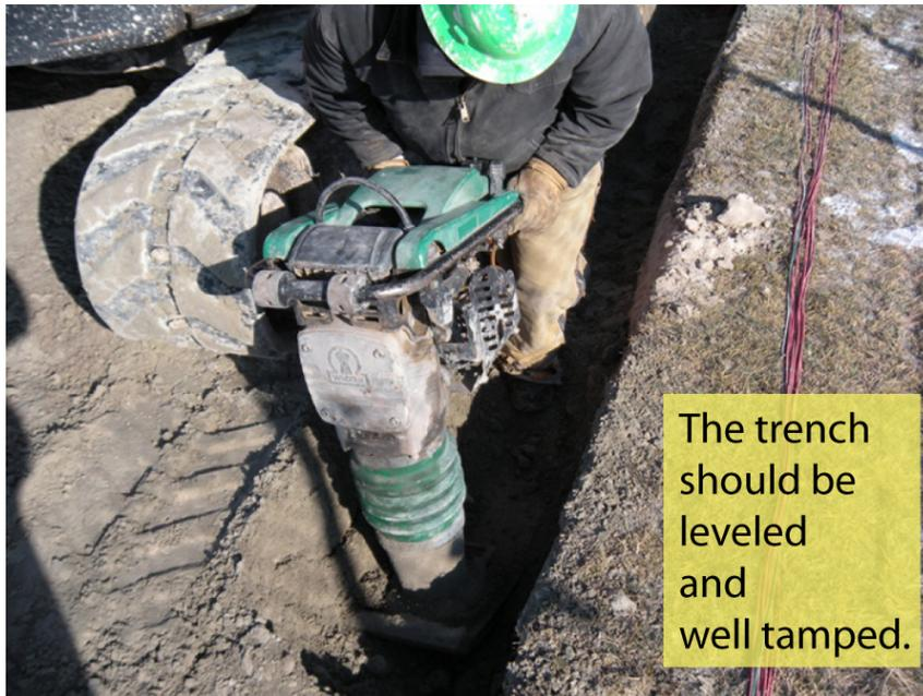
**Figure 4—Tamping the Conduit Trench**
