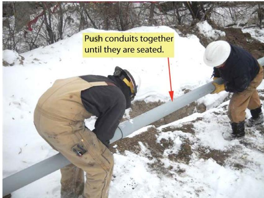
**Figure 25—Seating the Conduit**
